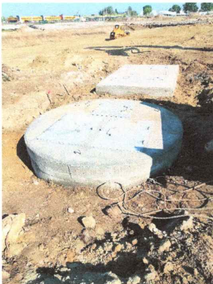
MOBA E20 átemelő és szerelvényakna
