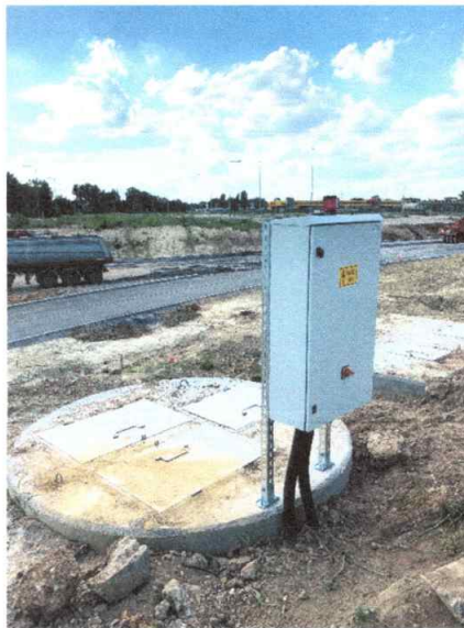
Flygt FGC400 vezérlőszekrény GSM/GPRS
